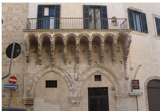
Veduta frontale della loggia
