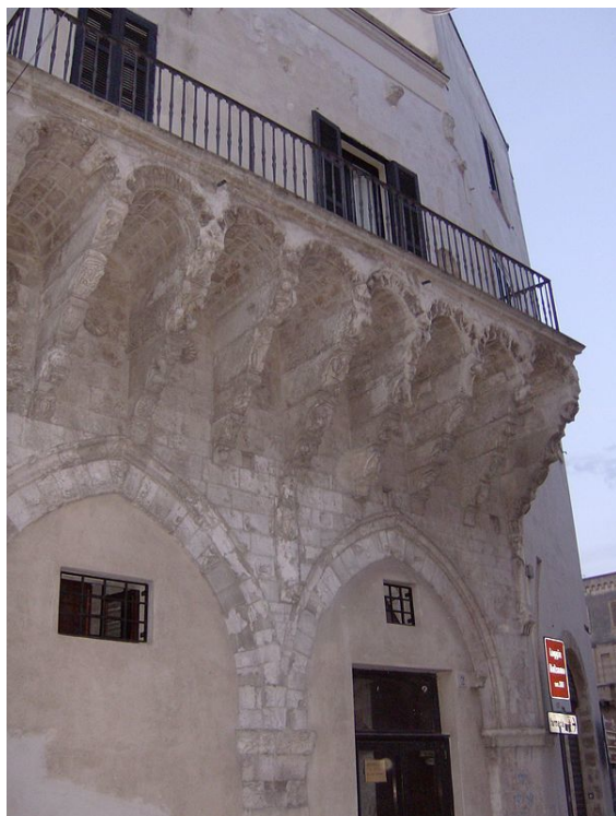
La loggia di palazzo Balsamo
